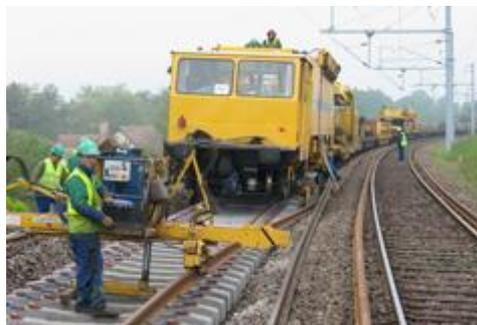
*Longs Rails soudés sur traverses béton*
